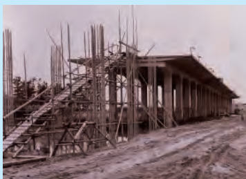
建設中の東海道新幹線 (安城南中学校附近、本市蔵)
