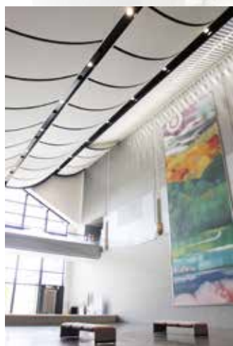
耐震化改修工事後のエントランスホール
