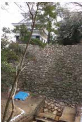
7 吉田城鉄櫓の野面積み石垣(豊橋市文化財センター提供)
